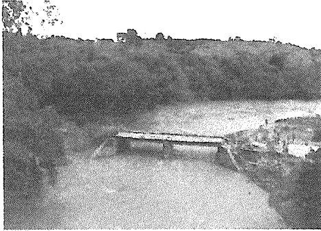
o) PONTE PÓS ENCHENTE Coordenadas: 24 L, 773708.00 m E, 8921952.00 m
